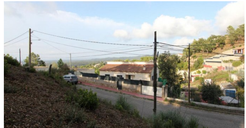
Spanien Baugrundstück bei Lloret de Mar
